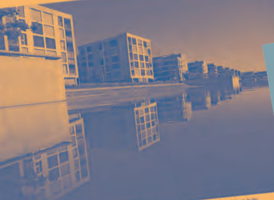
Leopold Bachmann hat, in den letzten Jahren, zahlreiche Grossbauprojekte realisiert. Der Quartier in Rüschlikon, Foto: A. Huber
